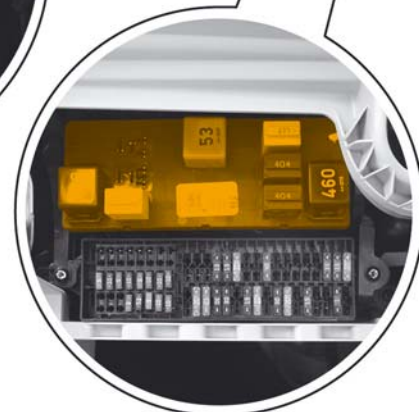
Relaisträger am Bordnetzsteuergerät, unter der Schalttafel links
